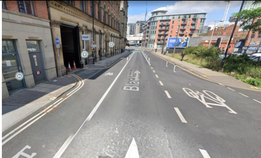
Μονοδρόμηση οδού και λωρίδες ποδηλάτων (μετά), Μάντσεστερ
