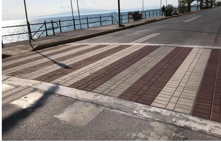
Περίπτωση αλλαγής υφής του οδοστρώματος στην θέση της διάβασης
