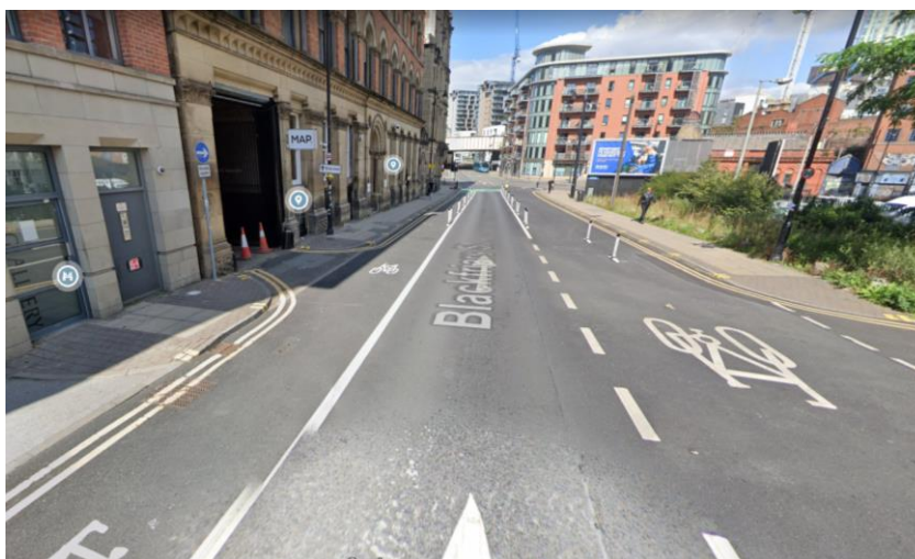
Μονοδρόμηση οδού και λωρίδες ποδηλάτων (μετά), Μάντσεστερ
