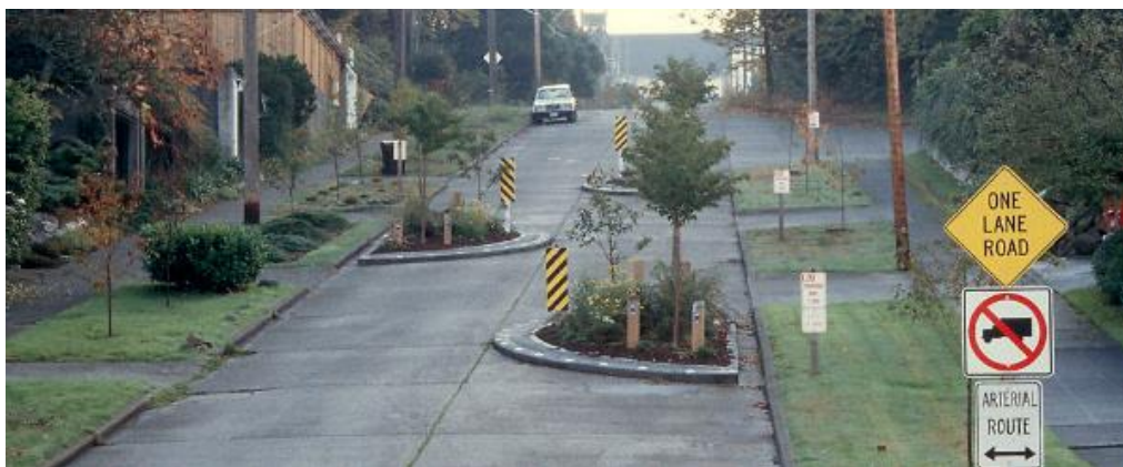
Παράδειγμα μεταβολών του άξονα της οδού, San Antonio. Η έντονη κλίση στην κατηφόρα (εάν δεν υπήρχαν τα πλευρικά εμπόδια που δημιουργούν τεθλασμένο άξονα οδού) θα οδηγούσαν στην ανάπτυξη υψηλών ταχυτήτων, κάτι που θα εγκυμονούσε κινδύνους στο χώρο της οδού
