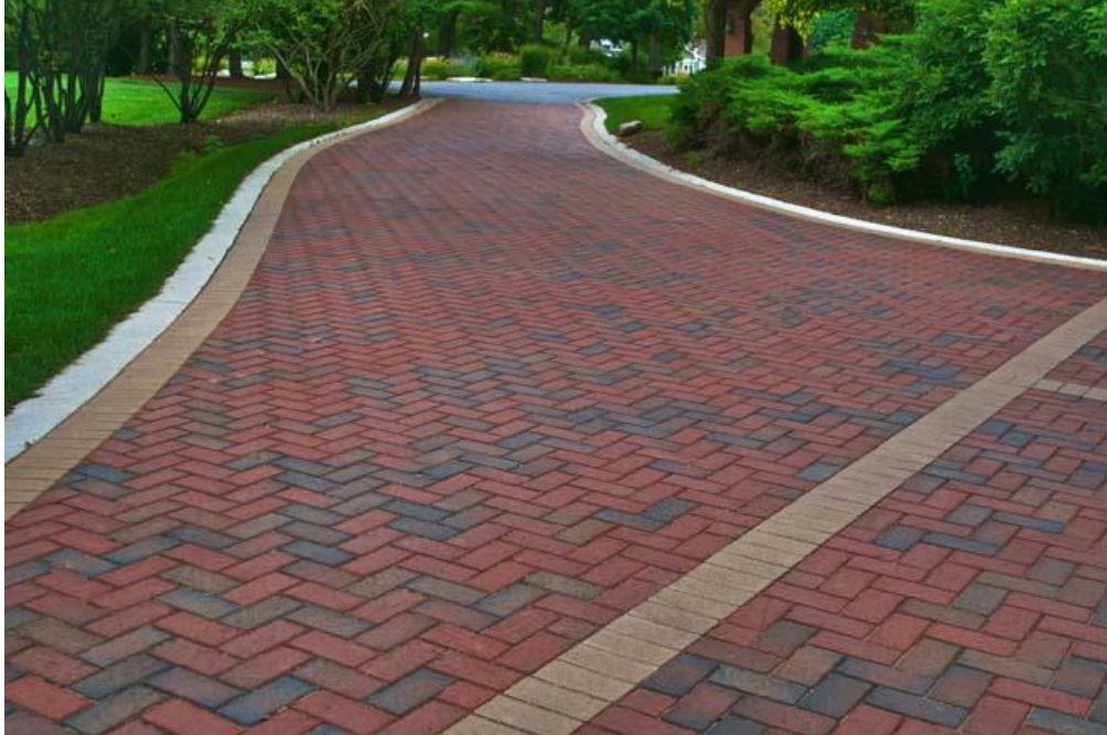
Αλλαγή υφής στο σύνολο του οδοστρώματος, Αμερική
